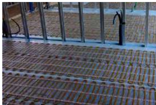
Installazione del sistema di riscaldamento Warmset a Sarmego (VI), abbinato a un massetto autolivellante.
