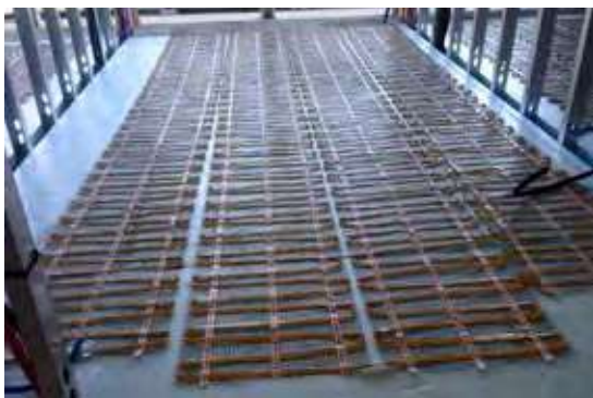
Installazione del sistema di riscaldamento Warmset a Sarmego (VI), abbinato a un massetto autolivellante.
